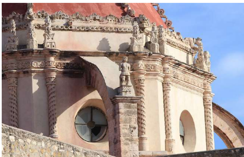
Fig. 17. Vista parcial de la cúpula, donde se observa el arbotante de soporte, un personaje español sobre el botarel, columnas caladas adosadas, grupos de pináculos, dragones a manera de gárgolas y demás decoraciones talladas en piedra.
